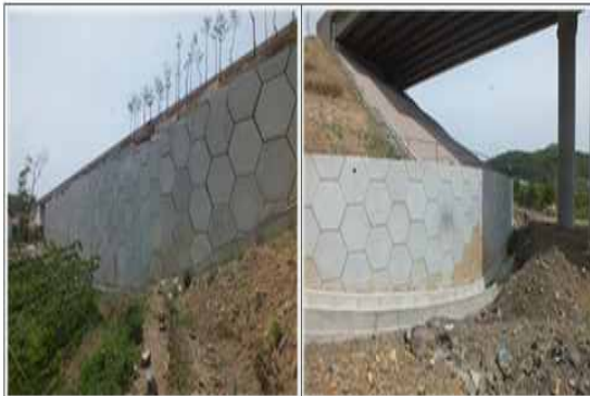
패널식 보강토옹벽 전면 전경
