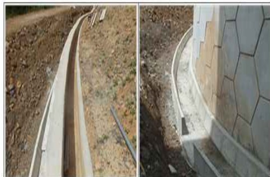
옹벽 상부 배수로 전경
