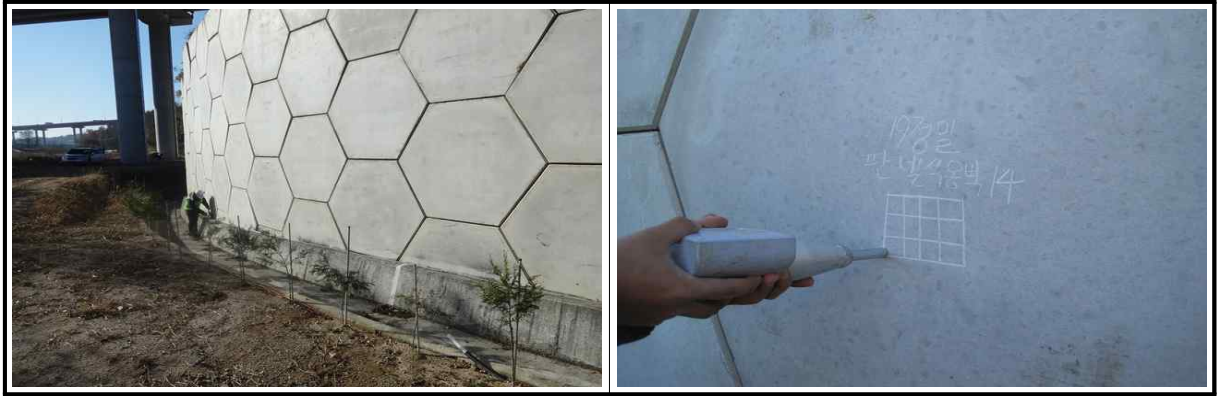
【그림 14.3.6】 슈미트해머를 이용한 반발경도시험 전경
